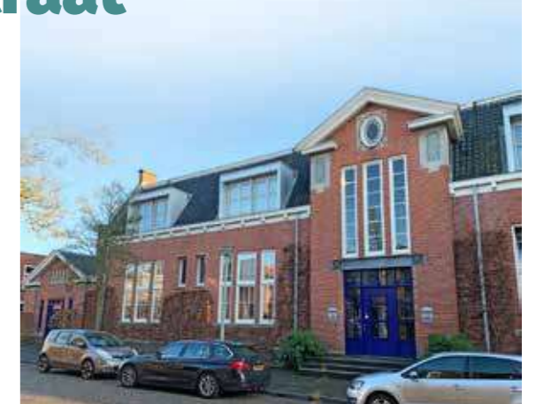
▲ De voormalige school in de Wassenberghstraat.
