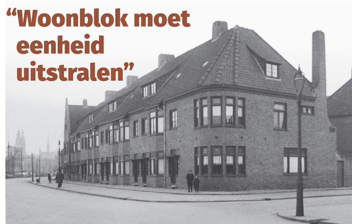
◄ Huizen aan de Hofstede de Grootkade op een foto uit 1927 in de oorspronkelijke kleursetting met veel donkergroen. Wel wat somber misschien. In dit blok, voor de hoek met de Taco Mesdagstraat, detoneren de dakkapellen niet. Dat is in het volgende blok richting watertoren heel anders. Foto: P.B. Kramer. Collectie Groninger Archieven
