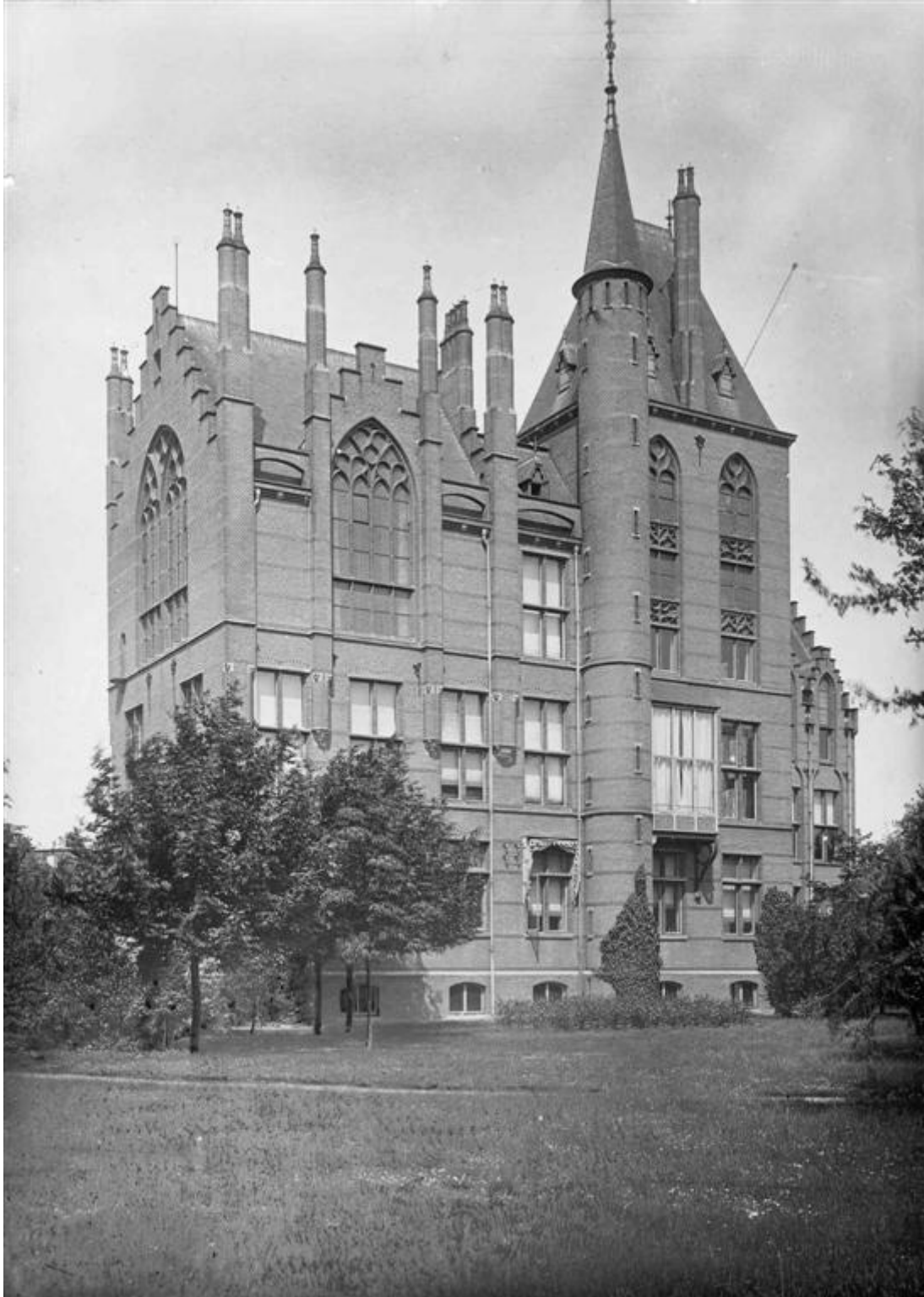
Melkweg 1, vlak na de bouw
